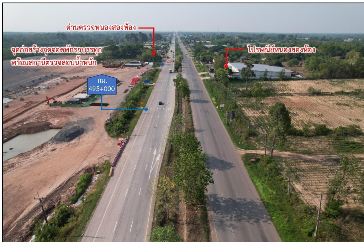
สภาพพื้นที่บริเวณโครงการก่อสร้างจุดจอดรถบรรทุกและสถานีตรวจสอบน้ำหนัก กรมทางหลวง
