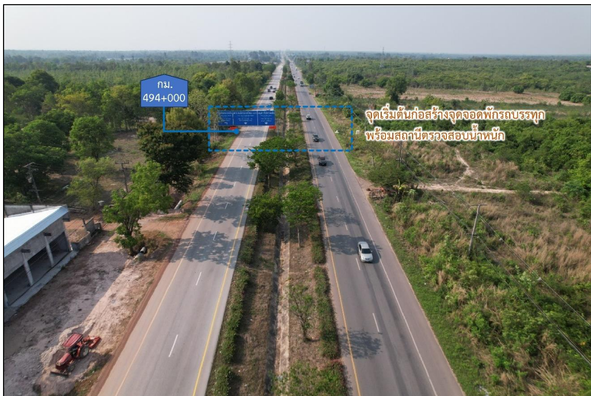
สภาพพื้นที่บริเวณจุดเริ่มต้นโครงการก่อสร้างจุดจอดรถบรรทุกและสถานีตรวจสอบน้ำหน้ก กรมทางหลวง
