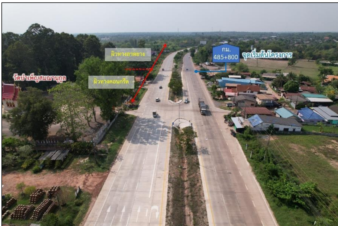
สภาพพื้นที่บริเวณจุดเริ่มต้นโครงการ กม.485+800
