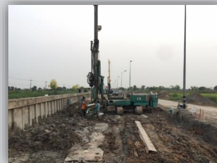
ดำเนินงานก่อสร้างเสาเข็มในช่วงเวลากลางวัน
