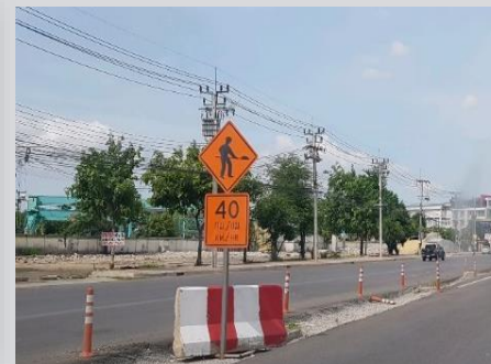
ติดตั้งป้ายจำกัดความเร็ว
