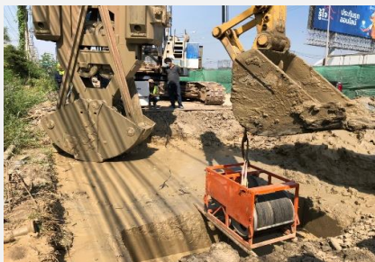
เปิดหน้าดินเฉพาะส่วนที่ดำเนินการ
