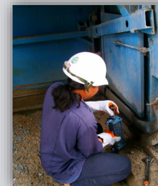
ตรวจตราและซ่อมบำรุงเครื่องยนต์เครื่องจักรที่ใช้ในการก่อสร้าง
