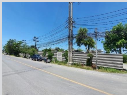
ติดตั้งกำแพงกันเสียงชั่วคราว
